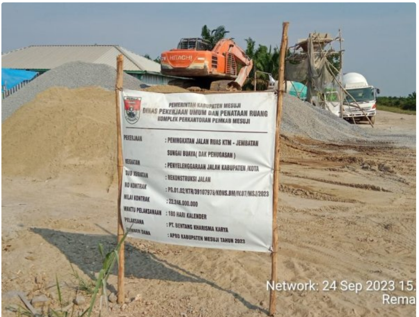
Pekerjaan rigit beton pada ruas penangkis Sungai Buaya Mesuji
